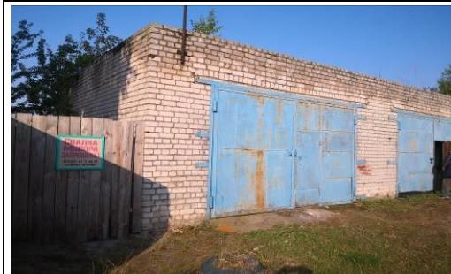
Характеристика объекта: **капитальное строение с инвентарным номером по государственной регистрации 400/С-152767 (гараж)** – одноэтажное здание гаража на 4 блока, фундамент – бетонный, наружные стены и перегородки - кирпичные, S общ. – 173,0 м<sup>2</sup>, перекрытия – железобетонные плиты, крыша – совмещенная рулонная, полы - бетонные, S застр. – 204,0 м<sup>2</sup>
