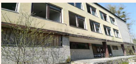
Административное здание Первомайский с/с, д. Ходилони Год постройки: 1985 Общая площадь (кв.м.): 304,0
